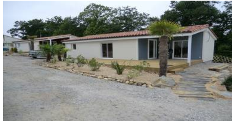
CHALET TERRA NOVA L-13 : EXTERIEUR
